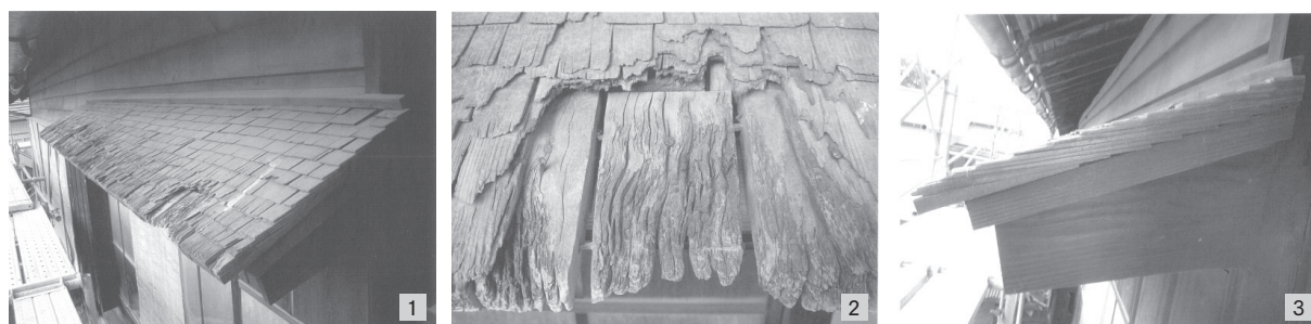
図7 | 主屋2階庇に残る板葺(北側)
