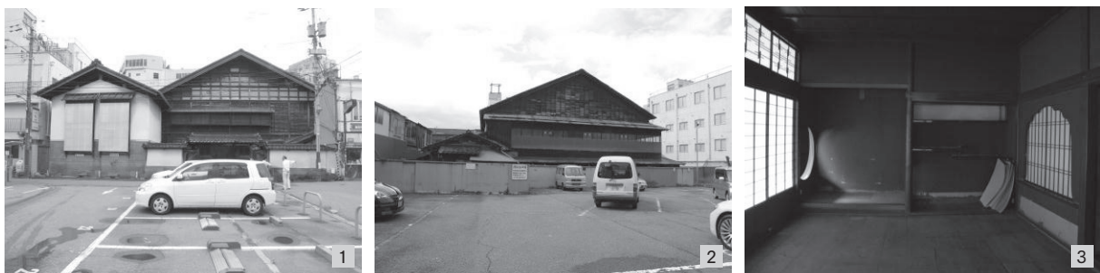
図4 | 旧佐野家住宅全景(修復前)
