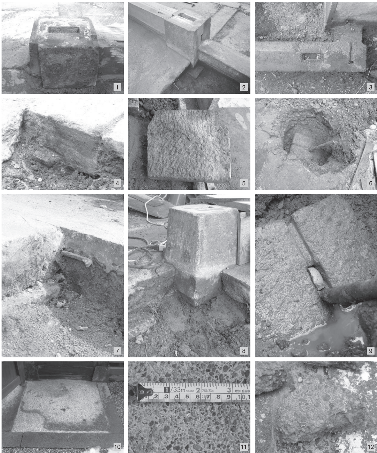
図18 | 基礎の技法概要
