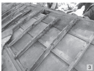
【野垂木】 背面側より見る
