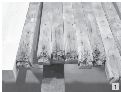
【化粧垂木】 棟木との取り付け部分
