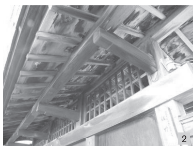
【化粧裏板】 [い一]付近からの見上げ
